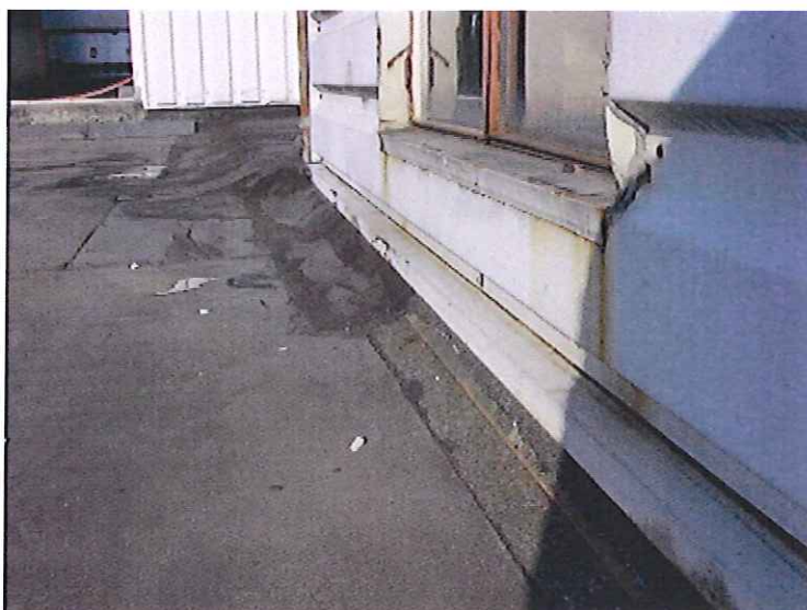
Foto 24 – aansluiting met opgaand werk
