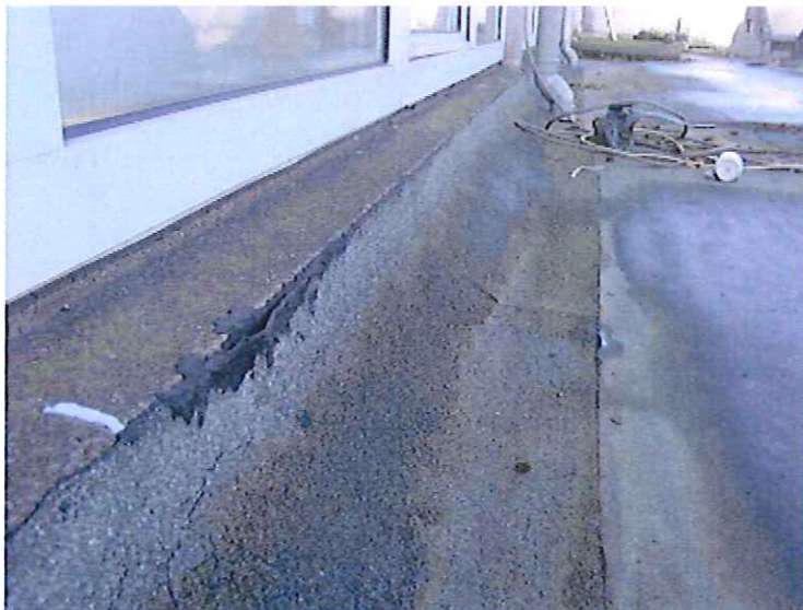
Foto 23 – aansluiting met opgaand werk
